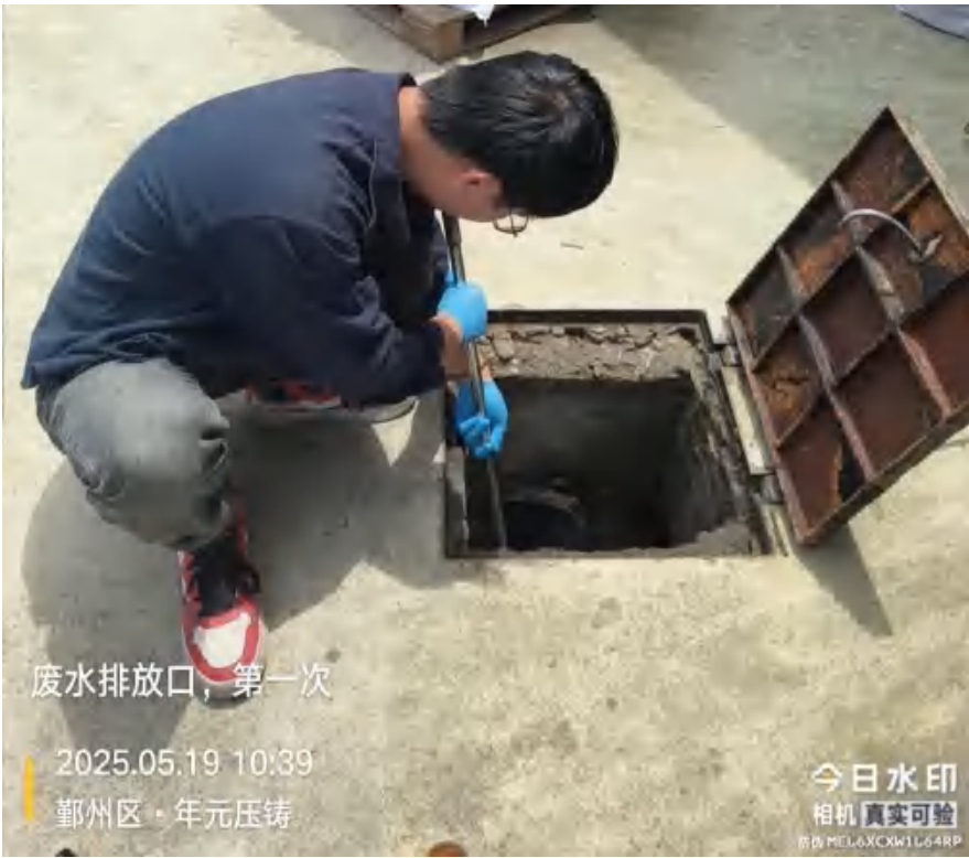
图 3-2 生活废水排放口照片
