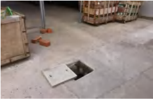
图 3-2 生活污水排放口
