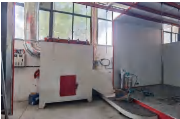
喷台喷塑废气处理设施 (DA004)
