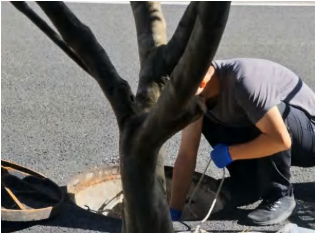
图 3-2 生活污水排放口照片
